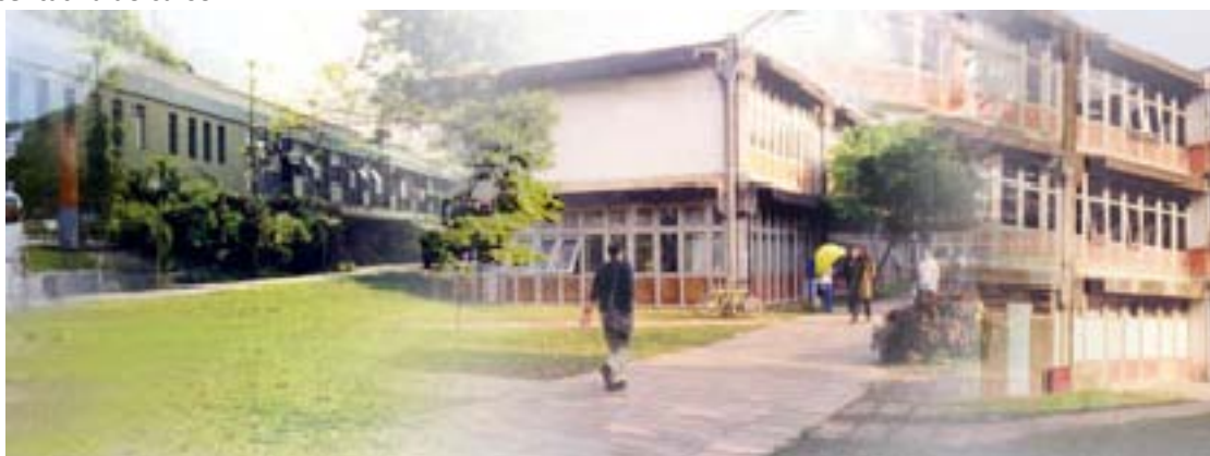
Prédio do Departamento de Ciências Sociais
